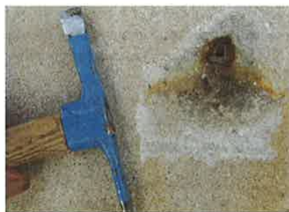
Jílová „pecka“ v jádrové omítce - jeden z nálezů při průzkumu
