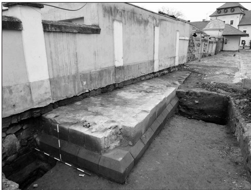
Obr. 1 Pohled od východu na odkrytou část hranolové věže (foto. Z. Schenk)
