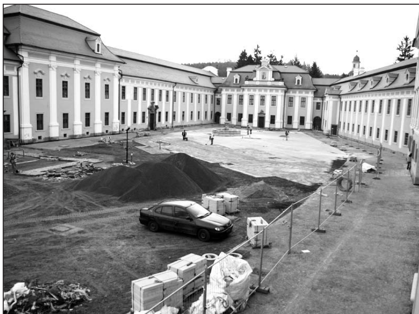
Pohled na plochu poutního nádvoří v průběhu dláždění (Foto P. Hudec)
